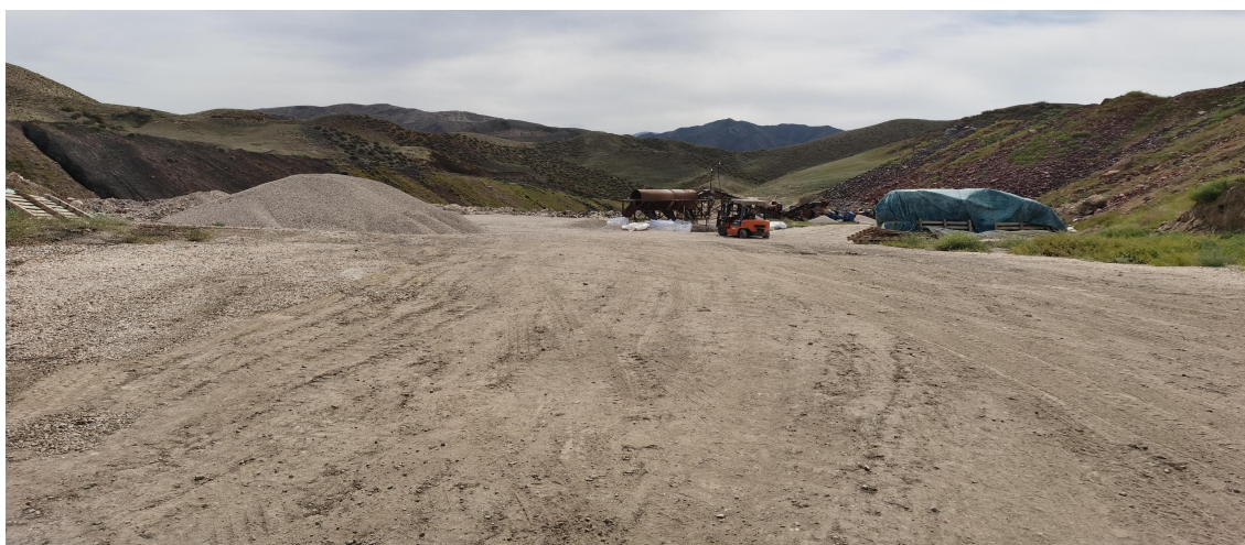
照片 5 工业广场现状.
